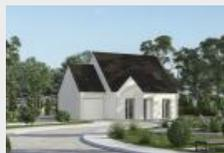
Cette maison à combles aménagés d'une surface habitable de 91 m² est construite sur vide sanitaire. Elle comprend 4 chambres, un séjour cuisine de plus de 33 m², une salle de bains équipée et un wc indépendant. Les menuiseries sont en PVC de couleur blanche. La toiture est réalisée en tuiles béton...
