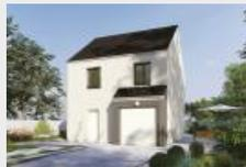
Cette maison à étage d'une surface habitable de 93 m² est construite sur vide sanitaire. Elle comprend 4 chambres, un séjour cuisine de plus de 39 m², une salle de bains, un WC indépendant et un garage intégré. Les menuiseries sont en PVC de couleur blanche. La toiture est réalisée en tuiles béton...
